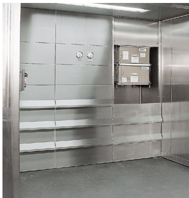
Filtertechniek in de achterwand
