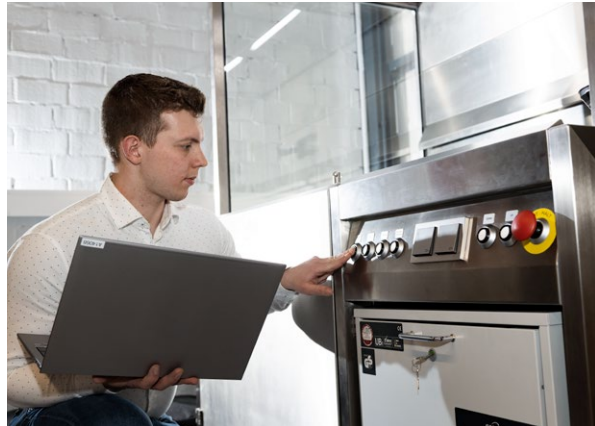
Inbedrijfname en Site Acceptance Test (SAT)
